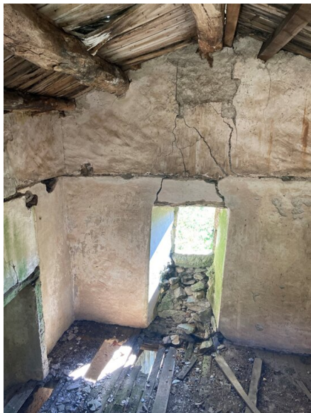
intérieur façade Sud
