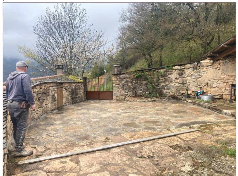
chantier de la cour haute achevé
