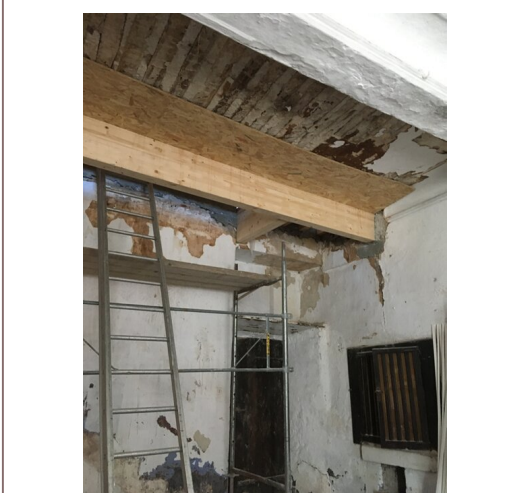
Travée effondrée restaurée et escalier posé
