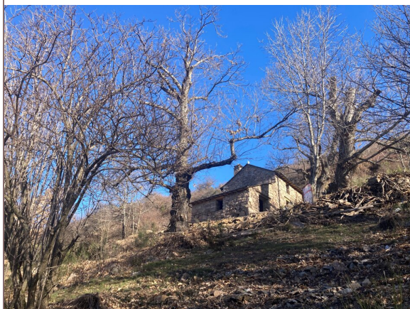
Première phase de restauration
