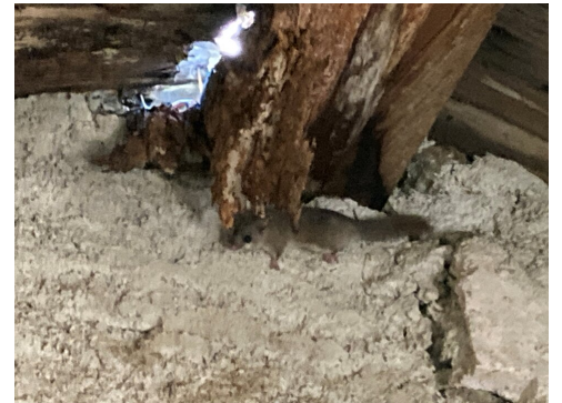
l'habitant des lieux (loir sous la poutre)
