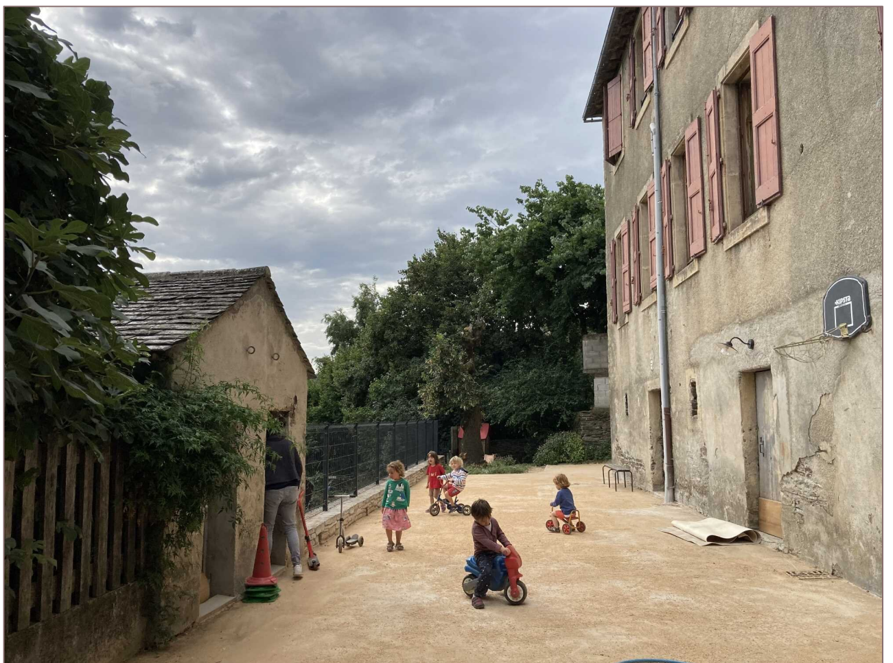
Cours de l'école après travaux de stabilisé à la chaux au lieu du goudron et 'un petit mur d'escalade dans le préau à l'entrée de la cours
