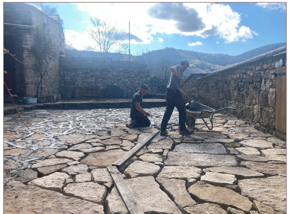
pendant le chantier
