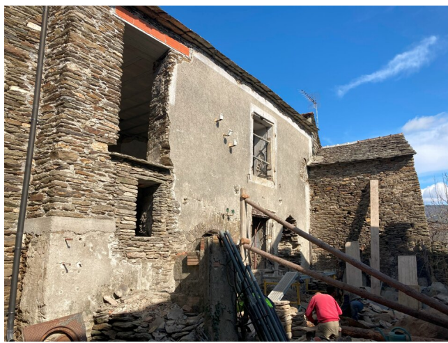
pendant le chantier
