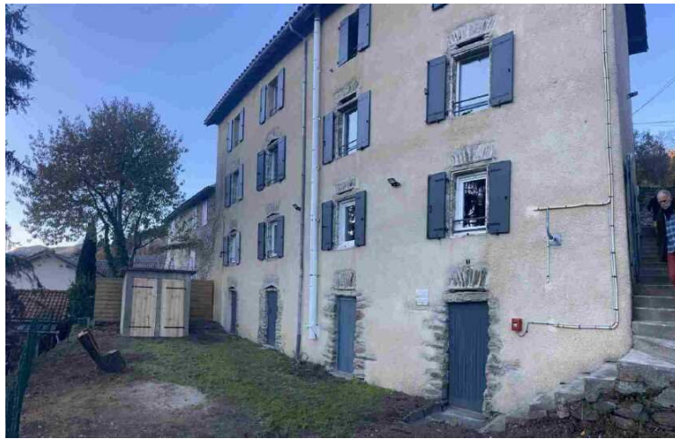
Façade Ouest après travaux
