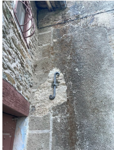
détail des "clés" des tirants
