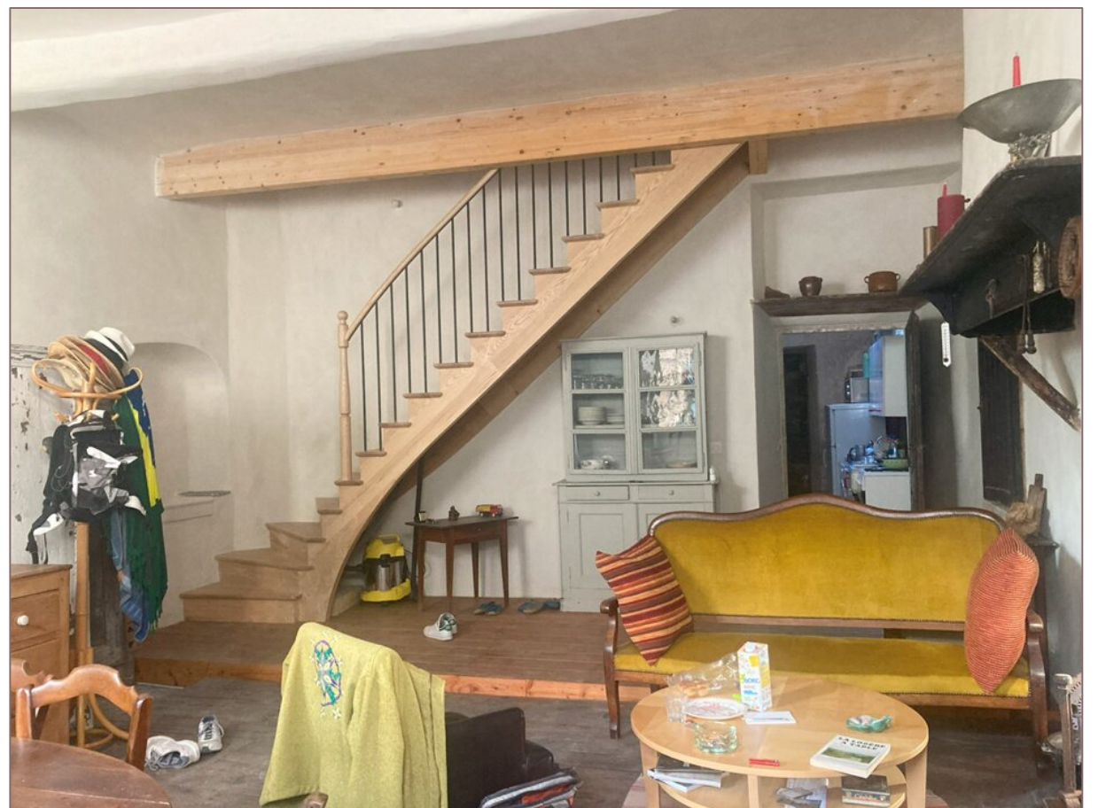
Finition chaux, plâtre en plafonds et tadelax dans la niche de l'escalier
