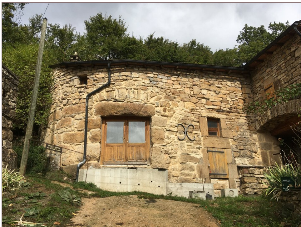
reprise en sous-oeuvre en béton condamnant l'accès à la maison
