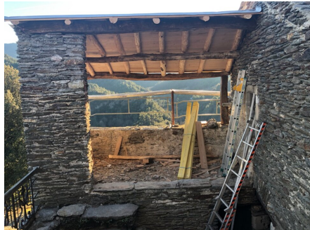
pendant le chantier
