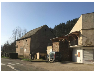
Auvent climatique en face sur escalier et autour du logement de fonction
