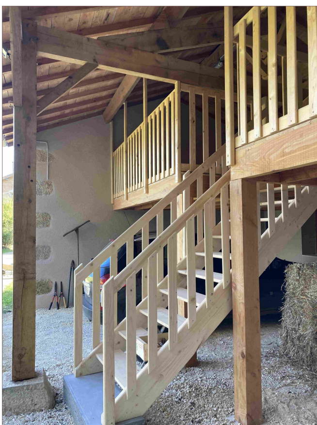
Façade Nord après travaux et détails de charpente et menuiserie
