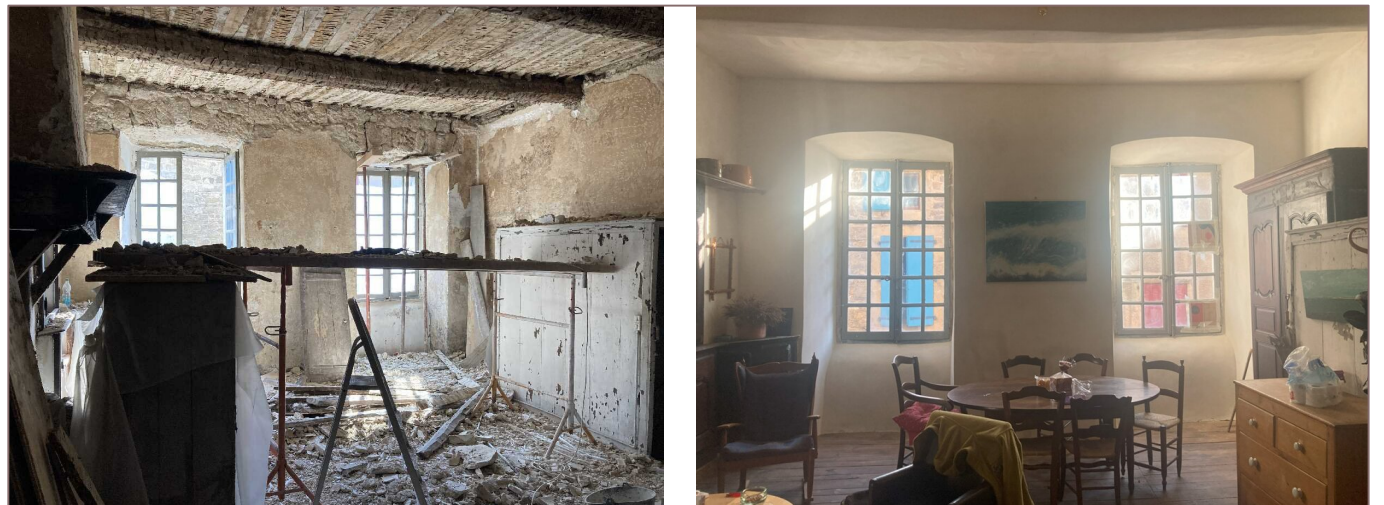
Premier étage pendant travaux puis finition murs chaux et liège (côté extérieur) et plafonds plâtre
