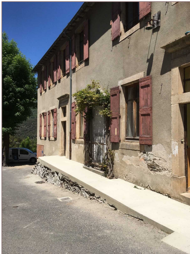
Nouvelle entrée école et rampe handicapés en cours de construction
