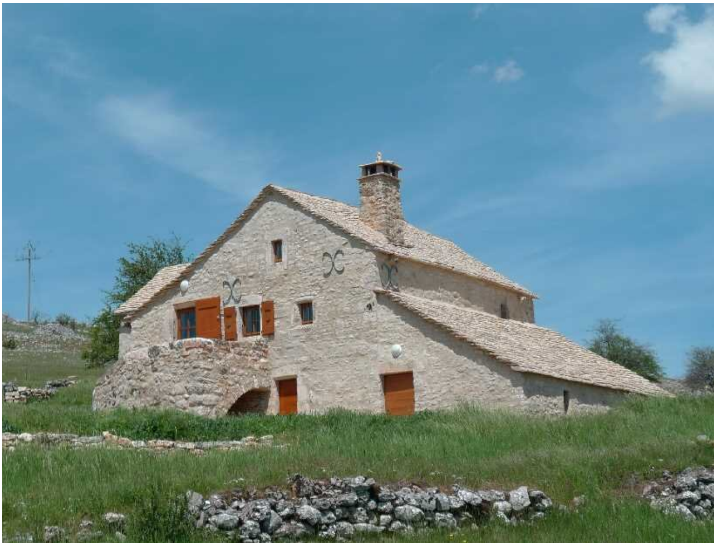
Le Villaret en 2012 - à la sortie du chantier
