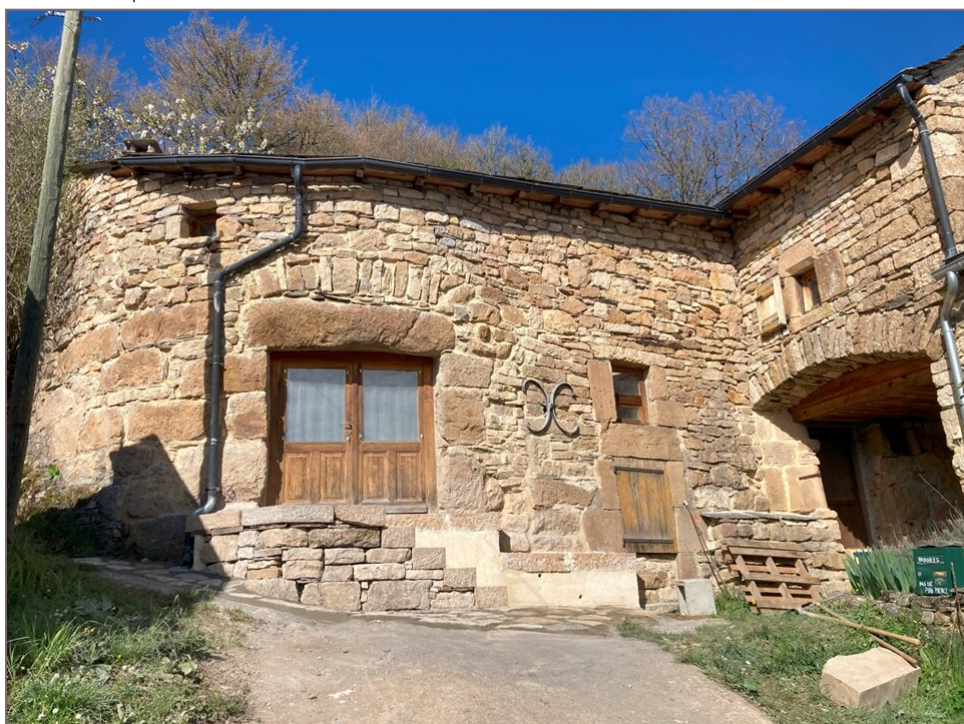
escalier et mur calcaire rétablissant l'accès à la maison
