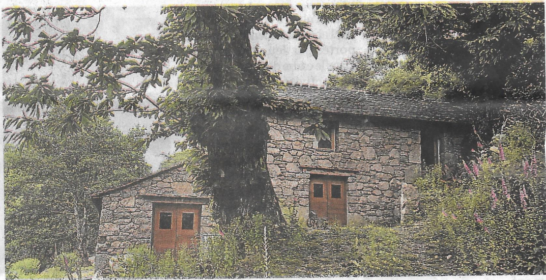
Le bâtiment après la restauration.
